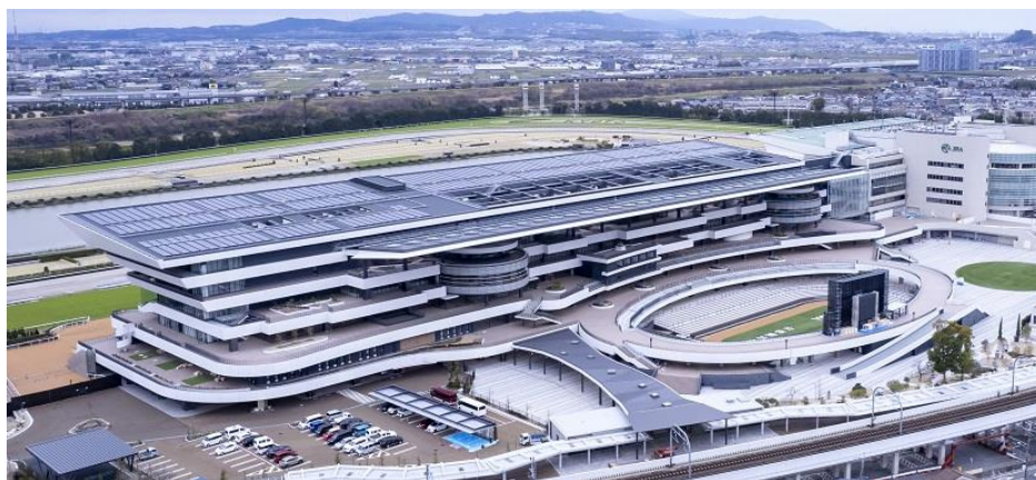
太陽光発電システム（京都競馬場）
