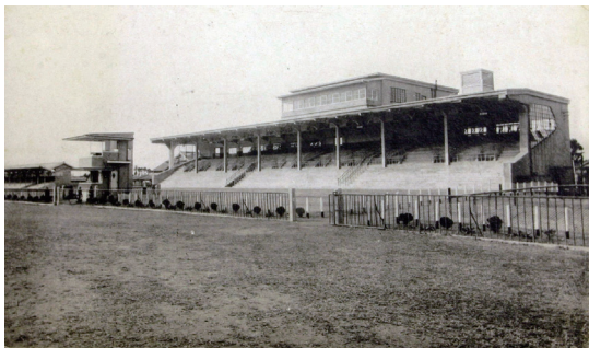
昭和10年頃の一等馬見所 東側からの外観
